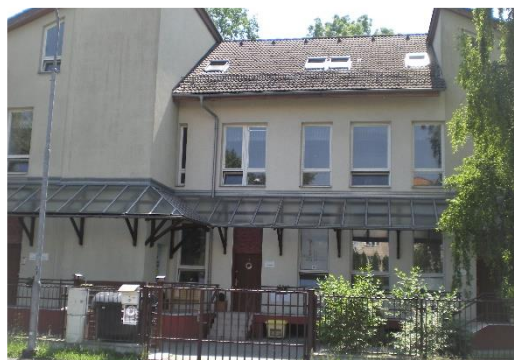
budova na ulici Fibichova
