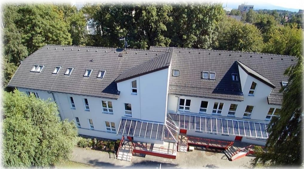
Budova na ulici Fibichova 469
