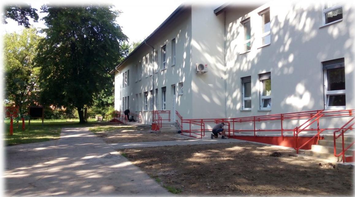
Druhá etapa- dokončovací práce na nových rampách a vstupech ze zahrady
