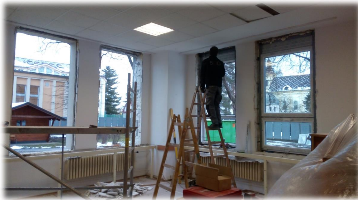
Výměna oken na denním stacionáři oddělení denního pobytu
